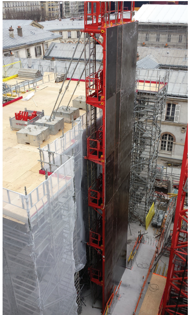
pose du voile ©Cyrille Castel
